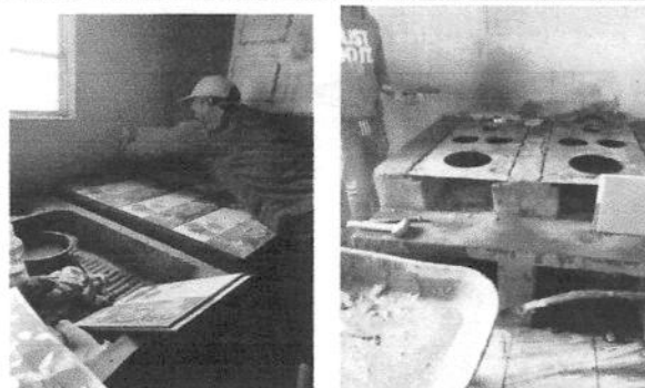
Foto 6: En las fotos se observaba la sustitución de plancha de metal de 3 homillas que son utilizadas para la cocina escolar.
